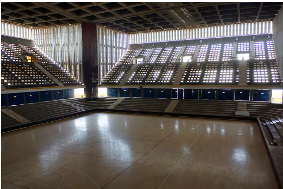
Die steil aufsteigenden Tribünentragwerke des Sports Palace in Form einer statisch unabhängigen, lichten Konstruktion aus grazilen Schrägbalken und Stützstreben
