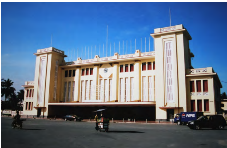
Erste Zeichen einer Moderne: Zentralbahnhof von Phnom Penh
