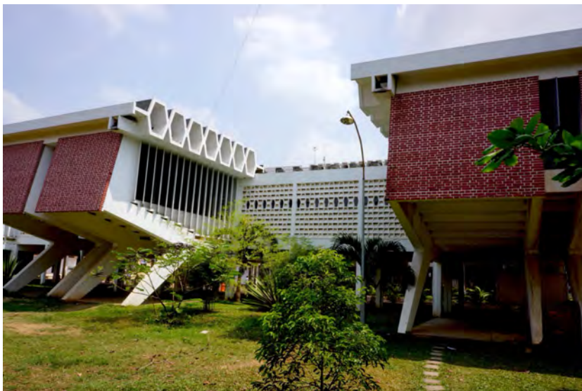
Main Building mit filigranen Seitenlamellen und einem wabenförmigen Dach
