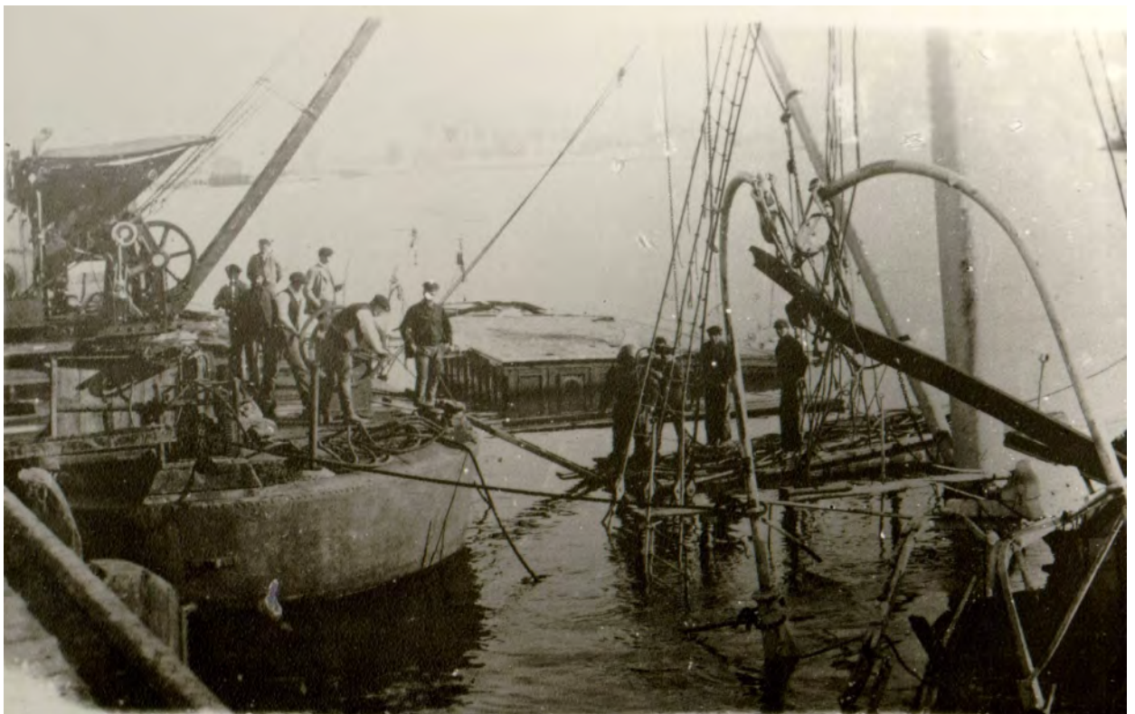
Bergungsarbeiten am gesunkenen Schiff, nach der ersten Explosion
