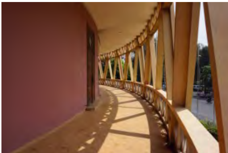
Der rundlaufende, in die Struktur eingehängte Balkon (2014)
