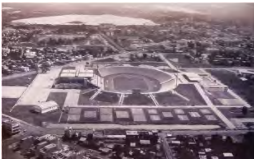
Gesamtansicht des National Sports Complex, im Hintergrund der heute zur Landgewinnung zugeschüttete Boeung Kak Lake
