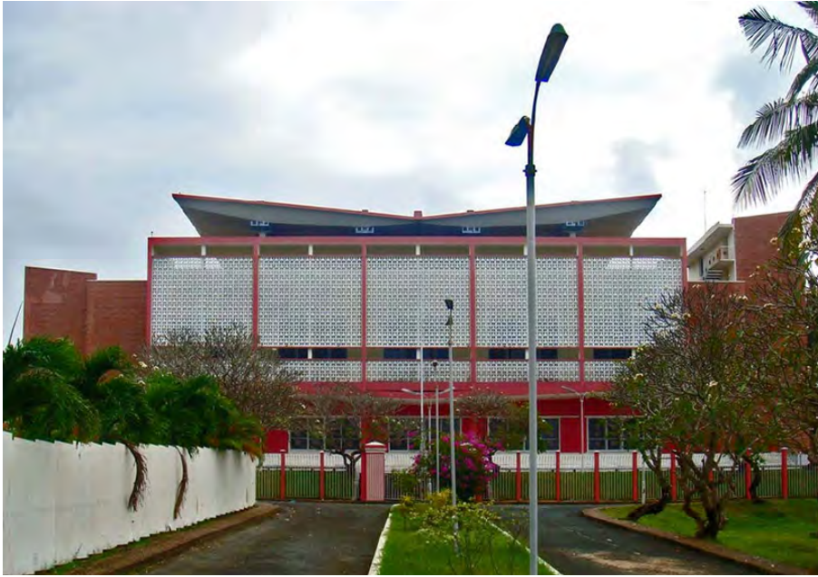
Banque Nationale du Cambodge, von den Roten Khmer 1975 beschädigt und in den 1980er-Jahren restauriert.
