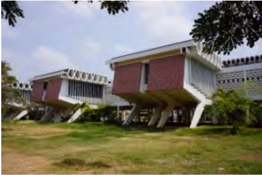
Das Main Building der Universität mit seinen filigranen Seitenlamellen und dem wabenförmig gefalteten Dach
