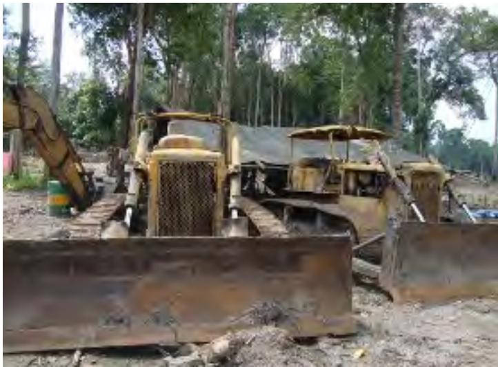
Bagger roden im staatlich geschützten Snuol Wildlife Sanctuary, um Platz für Plantagen zu schaffen
