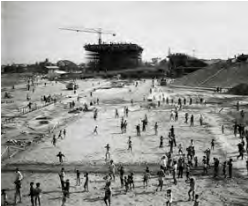
Bauarbeiten am National Sports Complex, im Hintergrund der Sports Palace mit seinen achttausend Sitzplätzen
