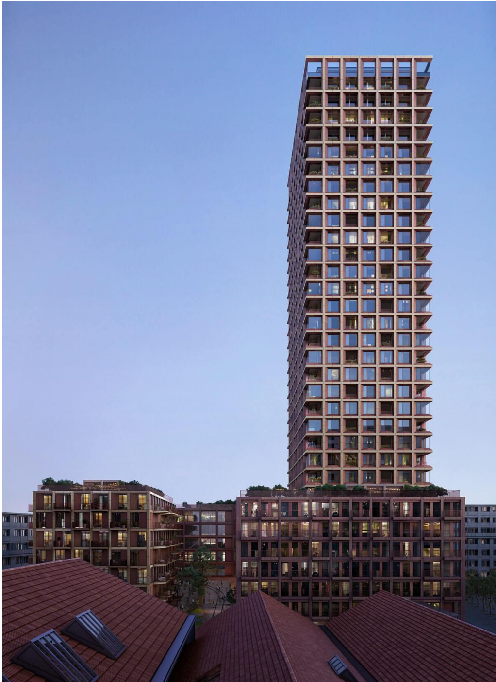
100 Meter hoch und mit Holzkern: Das geplante Hochhaus Rocket in der Lokstadt.
